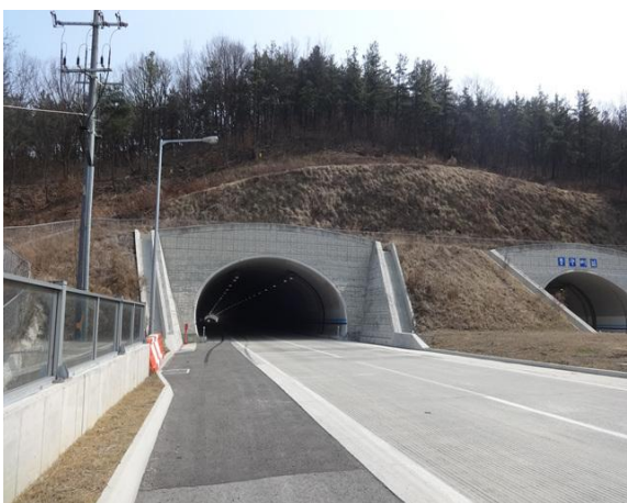
5공구 중구터널(상주방향) 시점부
