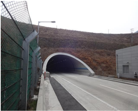
3공구 군위터널(상주방향) 시점부
