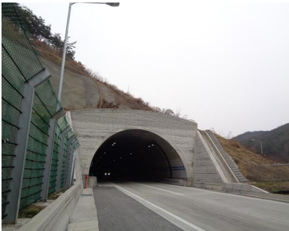
4공구 평호터널(상주방향) 시점부
