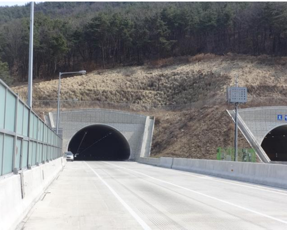
5공구 효령터널(상주방향) 시점부
