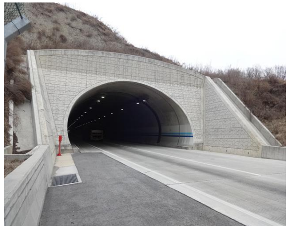
5공구 불로터널(영천방향) 종점부
