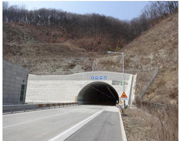
5공구 효령터널(상주방향) 종점부
