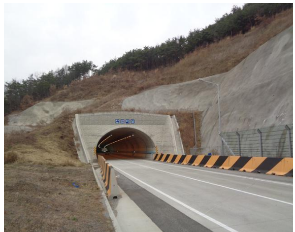
4공구 산법터널(상주방향) 종점부
