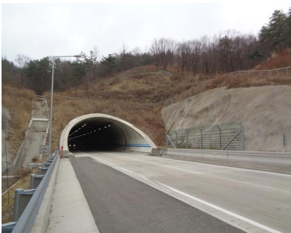
4공구 산법터널(상주방향) 시점부
