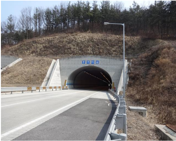
5공구 중구터널(영천방향) 시점부
