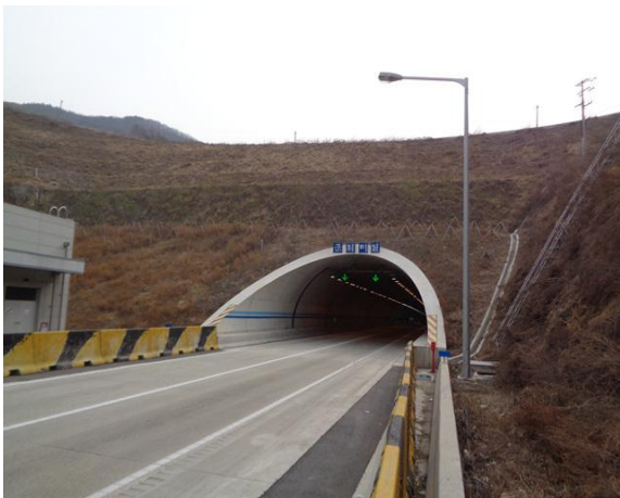
3공구 군위터널(영천방향) 시점부
