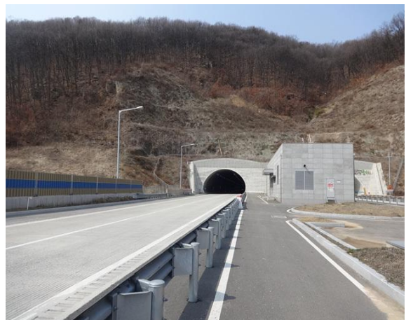
5공구 효령터널(영천방향) 종점부
