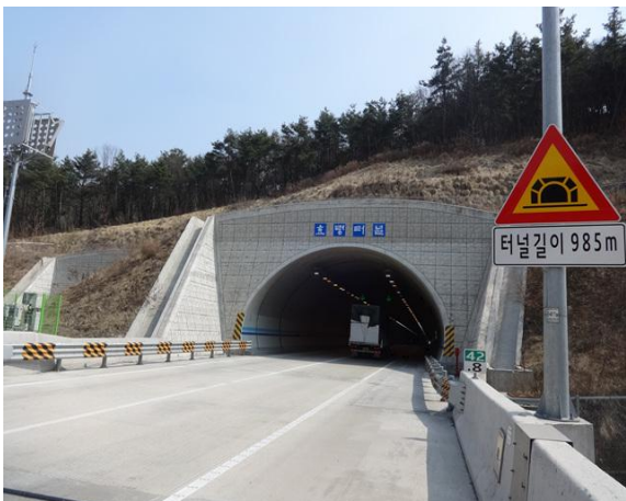
5공구 효령터널(영천방향) 시점부
