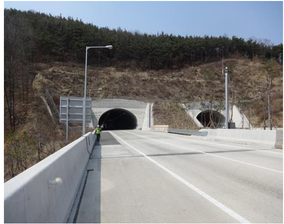
5공구 중구터널(영천방향) 종점부
