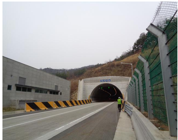
4공구 평호터널(상주방향) 종점부
