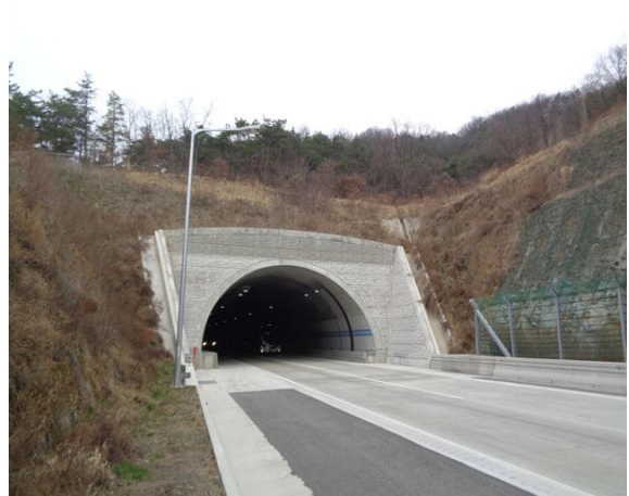
4공구 평호터널(영천방향) 종점부
