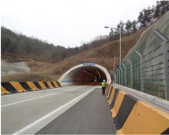
4공구 산법터널(영천방향) 시점부
