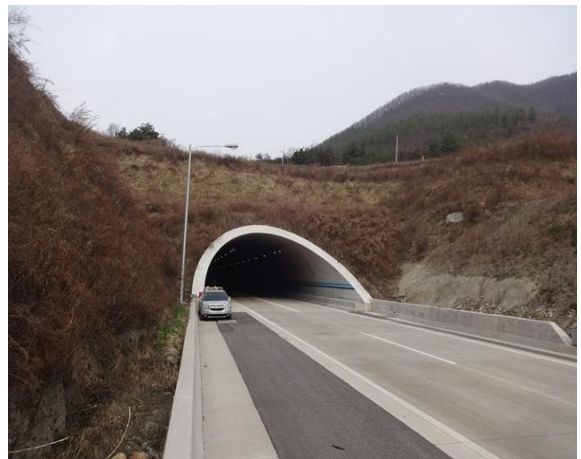
3공구 군위터널(영천방향) 종점부
