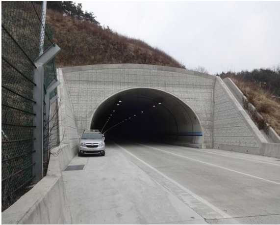
5공구 불로터널(상주방향) 시점부
