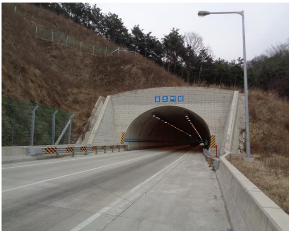
5공구 불로터널(영천방향) 시점부
