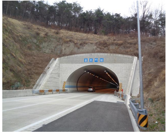
5공구 불로터널(상주방향) 종점부
