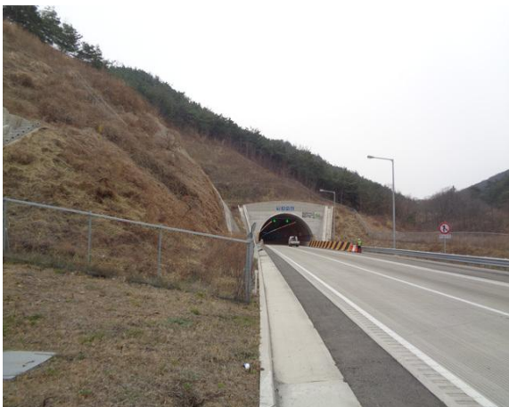
4공구 평호터널(영천방향) 시점부
