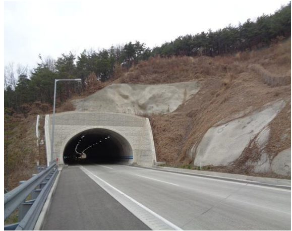
4공구 산법터널(영천방향) 종점부
