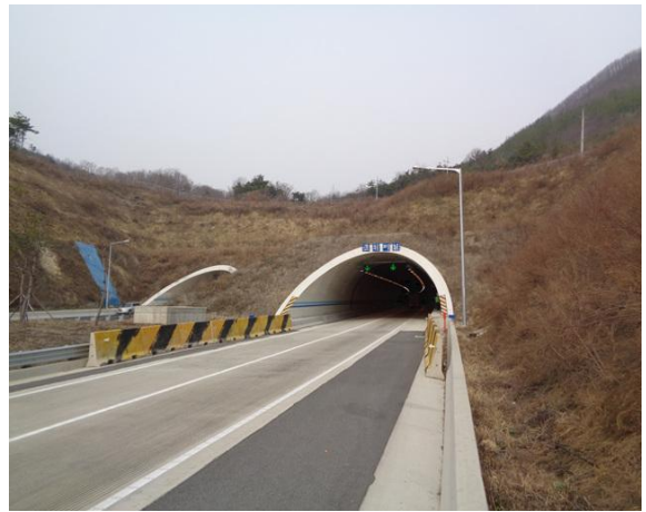
3공구 군위터널(상주방향) 종점부
